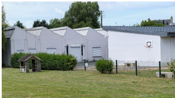
Les chantiers BONNE
