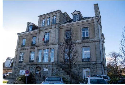
Vue arrière de la Mairie.
