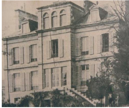
Vue arrière de la maison.
