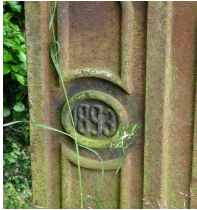
Pont de chemin de fer. « 1893 ».
