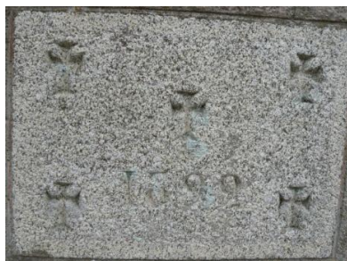
Pierre gravée côté Est de l'Eglise. « 1892 », pierre de fondation.
