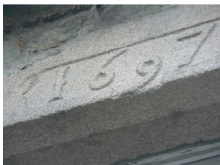
Linteau de fenêtre.
