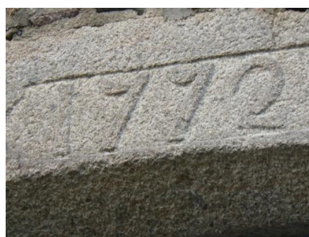
Linteau de fenêtre.
