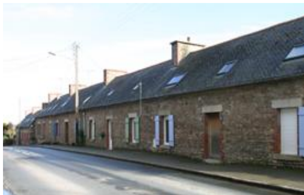
Les 6 maisons Jacob de la rue de Penvern.
